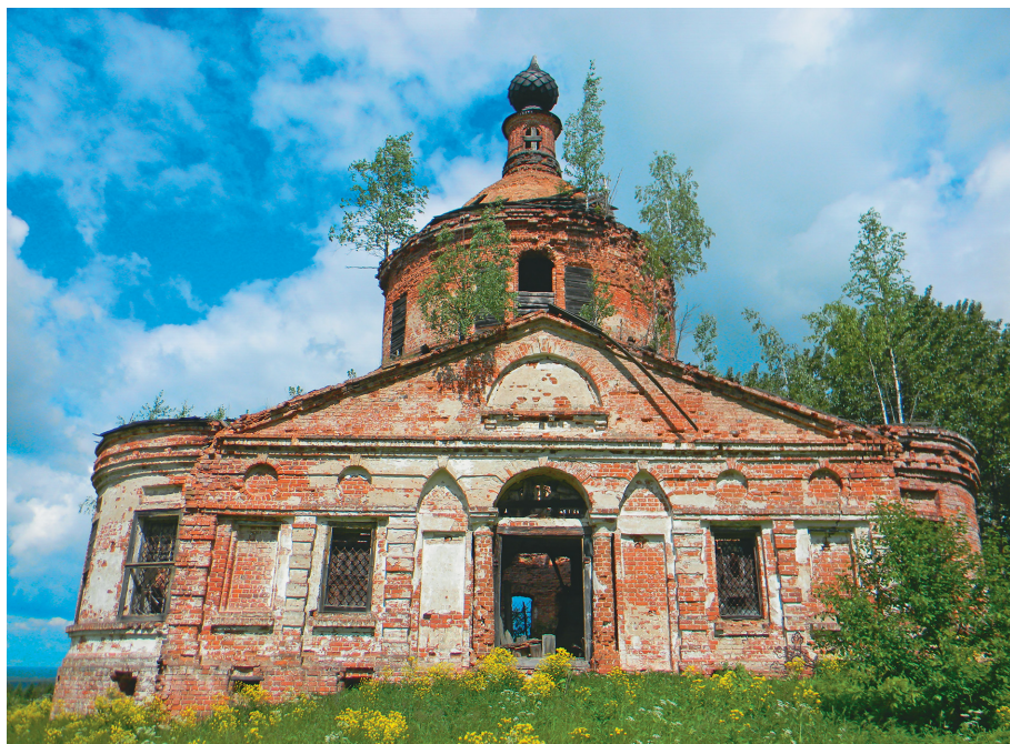
Фото 3. Вид с юго-востока. Фасад храма.
