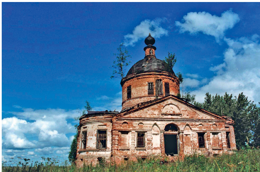
Фото 1. Вид с юго-востока. Фасад храма.
