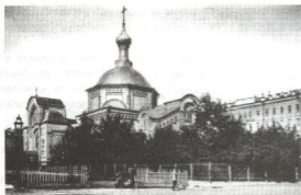
Церковь Свв. Космы и Дамиана, разрушена, на съёмъ станции метро «Чернышевская».
