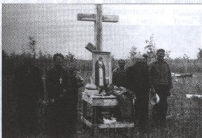
Строители «Града Китежа» — Скита Преп. Серафима в Каналь: Иеромонахъ Илія направо отъ Креста, снимаетъ. Владыка Іоасафъ. 1937 г.
