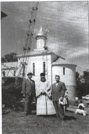
Три друга при строящемся Покровскомъ храмѣ.
