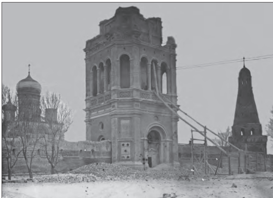
Симонов монастырь. Разрушение. Фотография 1929 г.
