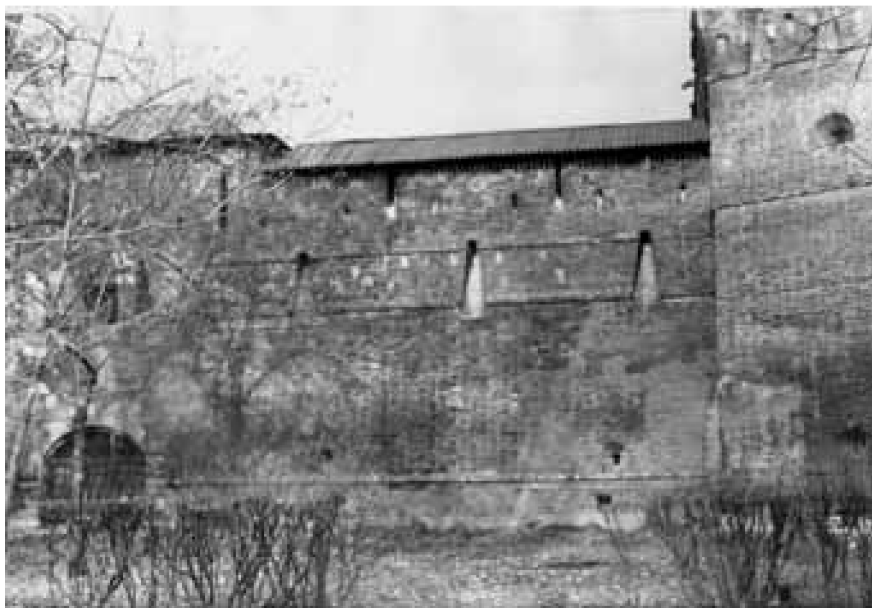
Южное прясло стены у Кузнечной башни в процессе реставрации. 1960-е гг.
