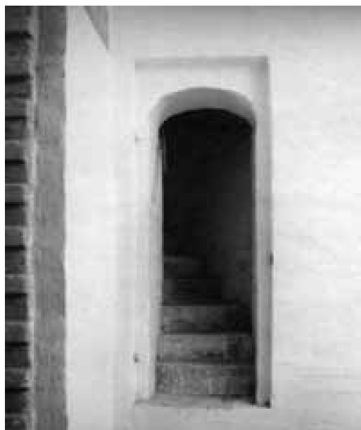
Новая трапезная. Восстановленная часть внутрестенной лестницы, вид со стороны сеней
