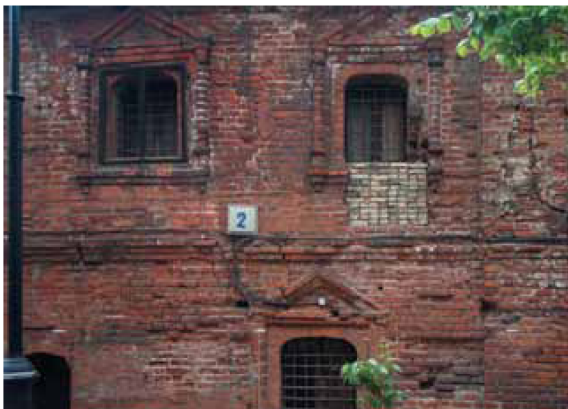
29. Сушило. Фрагмент северного фасада. Июнь 2008 г.
