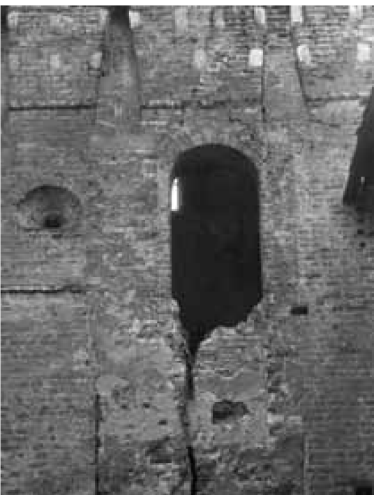
Кузнечная башня, восточный фасад. Примыкание верха монастырской стены и проём в башню. 1980-е гг.
