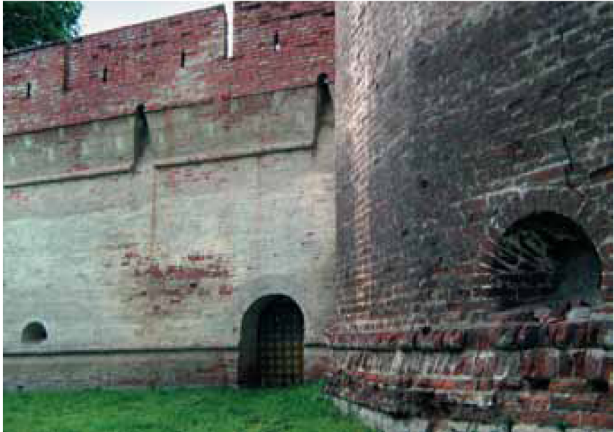
12. Восстановленная «вьлазная» калитка в восточном прясле южной стены. Вид с юга. Май 2016 г.
