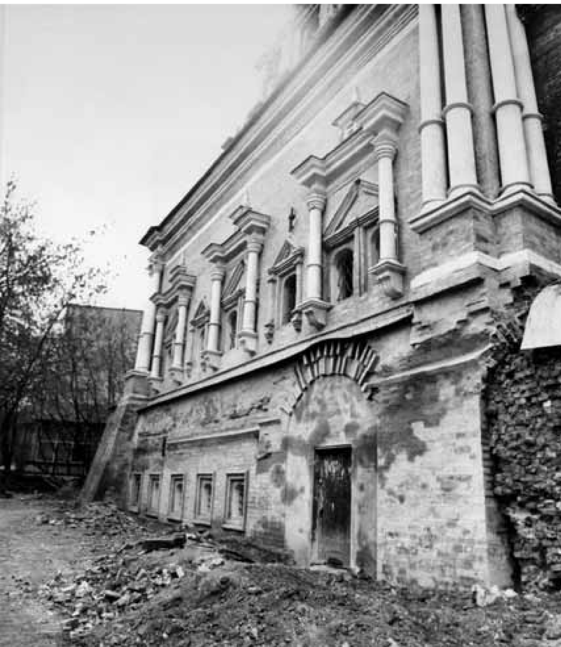
Новая трапезная. Западный фасад в процессе реставрации
