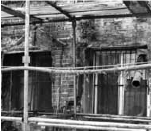
Новая трапезная. Восточный фасад. Растёсанные окна 1-го этажа. 1983 г.
