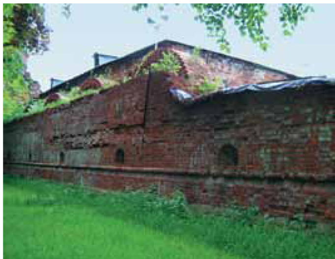
10. Примыкание восточного прясла южной стены к Кузнечной башне. Верх стены не восстановлен. Май 2016 г.
