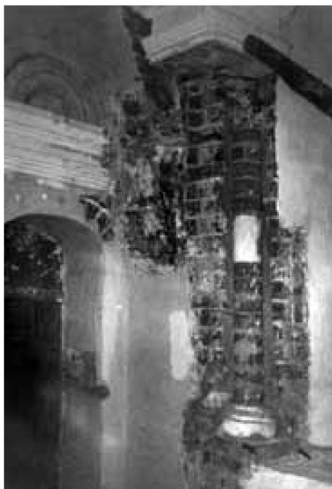
Новая трапезная. Откос первоначального окна южной стены в процессе восстановления. Слева – дверь в «моленную палатку»
