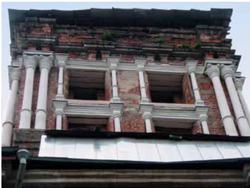
22. Новая трапезная. Северный фасад. Башня-смотрильня после проведения реставрационных работ по восстановлению кладки. Июнь 2008 г.
