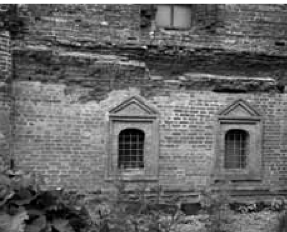
Сушило. Северный фасад. Фрагмент 1-го этажа. Июнь 2008 г.
