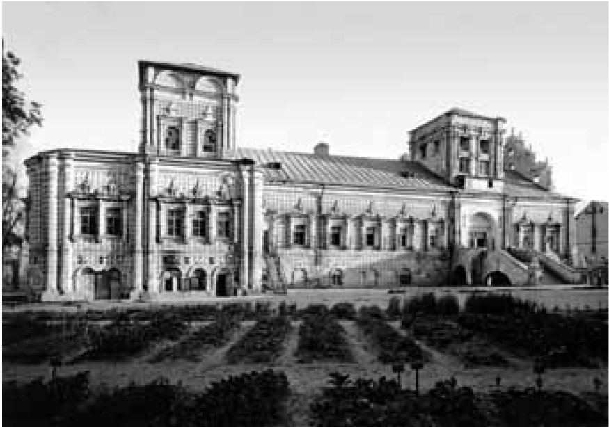
Новая трапезная. Северный фасад. ГНИМА, ГУОП–4722
