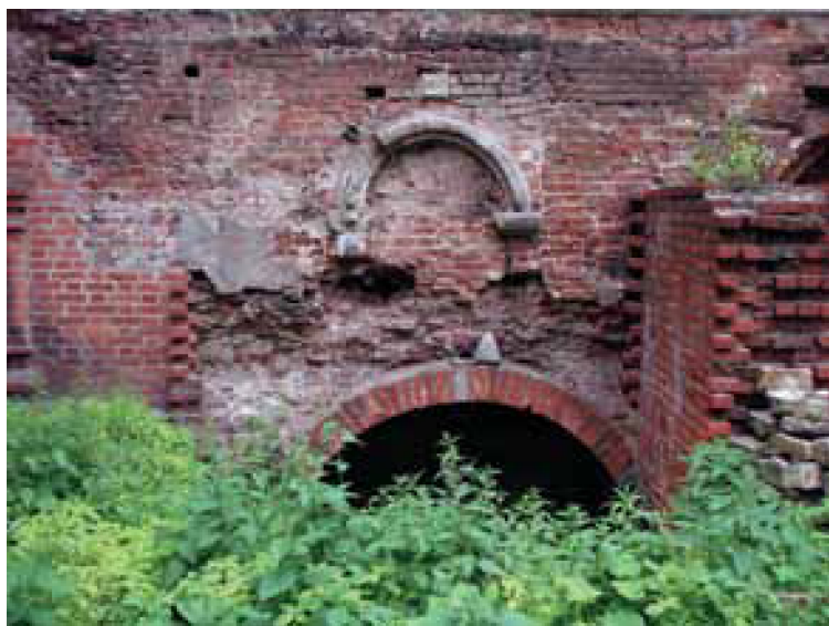
17. Новая трапезная. Восстановленная арка входа в восточную часть подвала. Июнь 2008 г.
