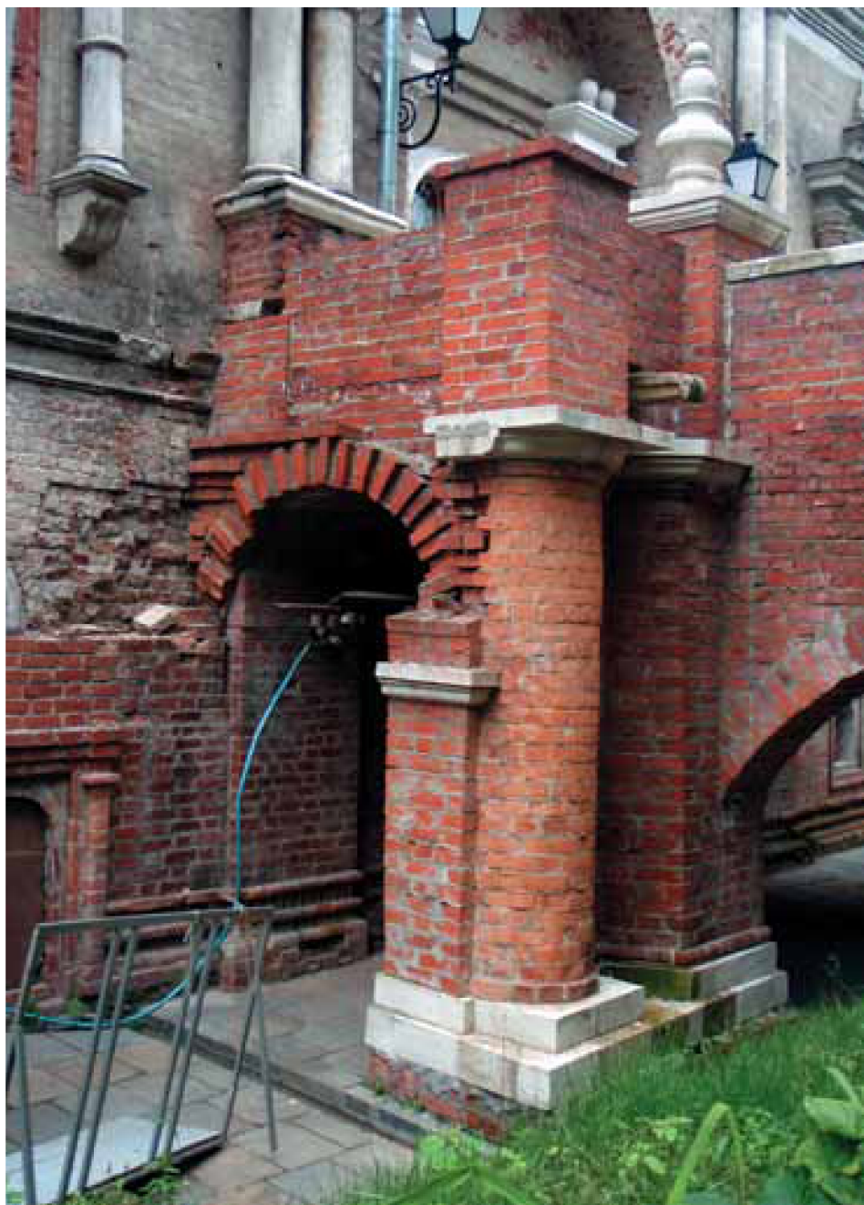
19. Новая трапезная. Восстановленная кладка столба галереи у крыльца. Июль 2008 г.
