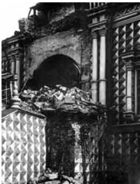
Новая трапезная. Крыльцо после обрушения в 1928 г. ГНИМА, V-23305
