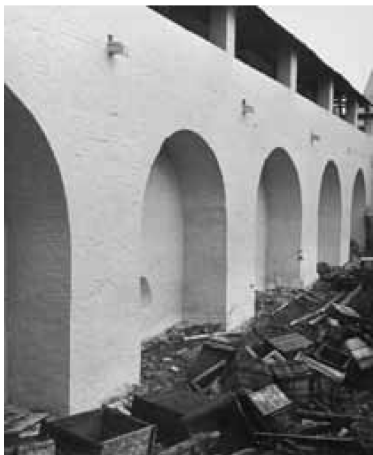
Южное прясло стены за Сушилом. Вид после реставрации. 1960-е гг.
