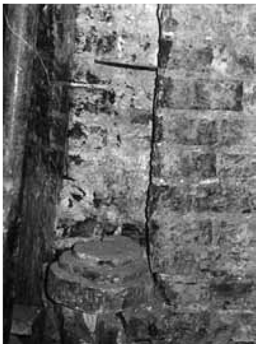
Новая трапезная. Откос первоначального окна с найденной базой колонки
