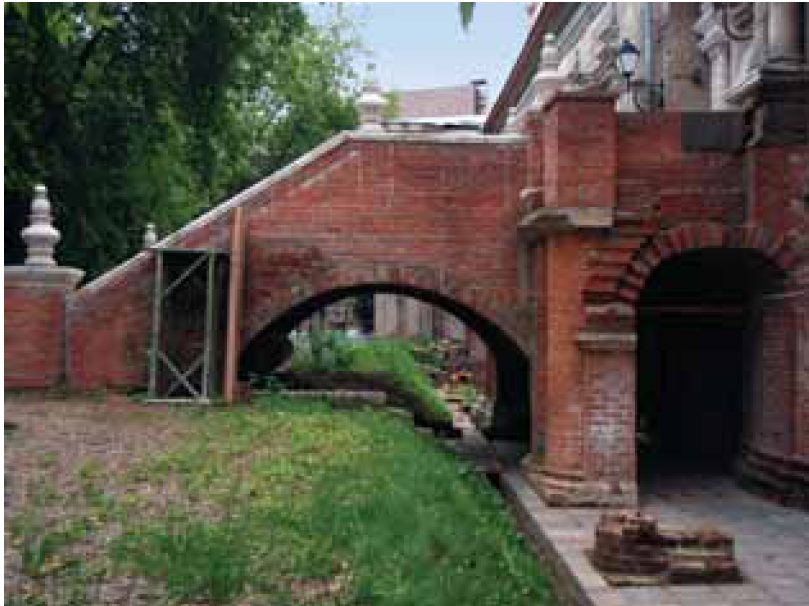
20. Новая трапезная. Восстановленное крыльцо. Вид с запада. Июнь 2008 г.
