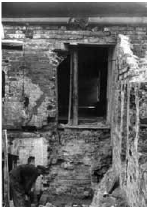
Южные ворота, западная стена. Восстановление растёсанного дверного проёма выхода на крепостную стену. 1960-е гг.
