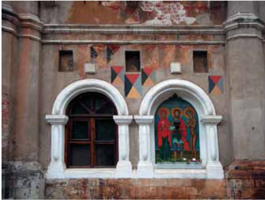
25. Новая трапезная. Северный фасад. Выкраски для проверки цвета росписи в шашку. Июнь 2008 г.
