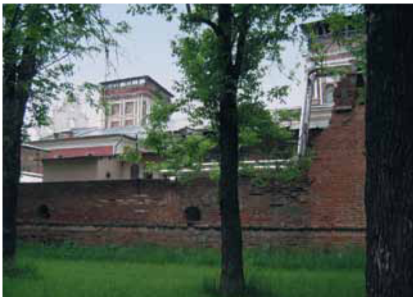
28. Новая трапезная. Вид верхних объёмов из-за недостроенной восточной части южной стены. Май 2016 г.
