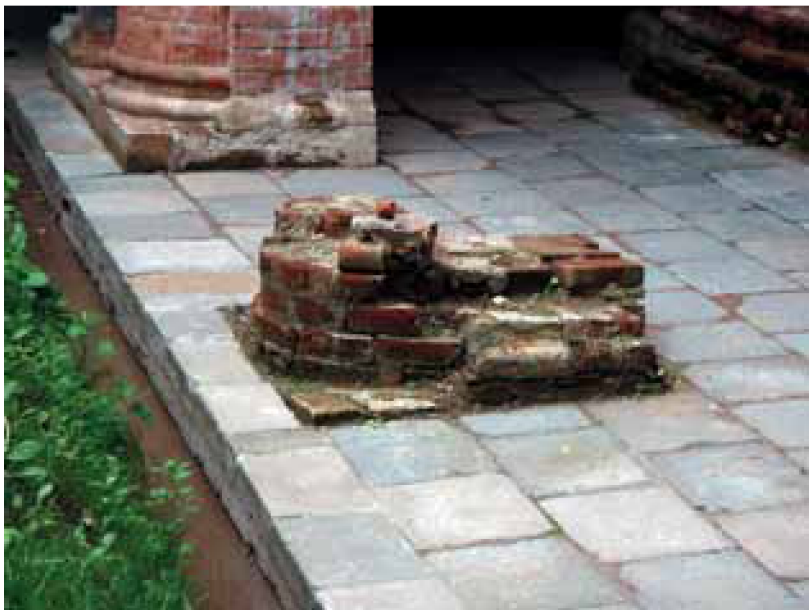
21. Новая трапезная. Законсервированная кладка основания столба галереи. Июнь 2008 г.
