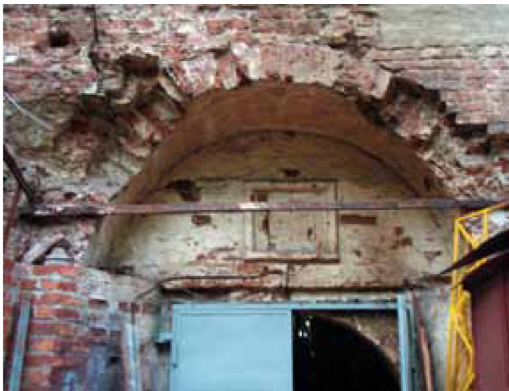
16. Новая трапезная. Северный фасад. Раскрытый от закладки вход в подклет (подвал) на уровне 1-го этажа. Июнь 2008 г.
