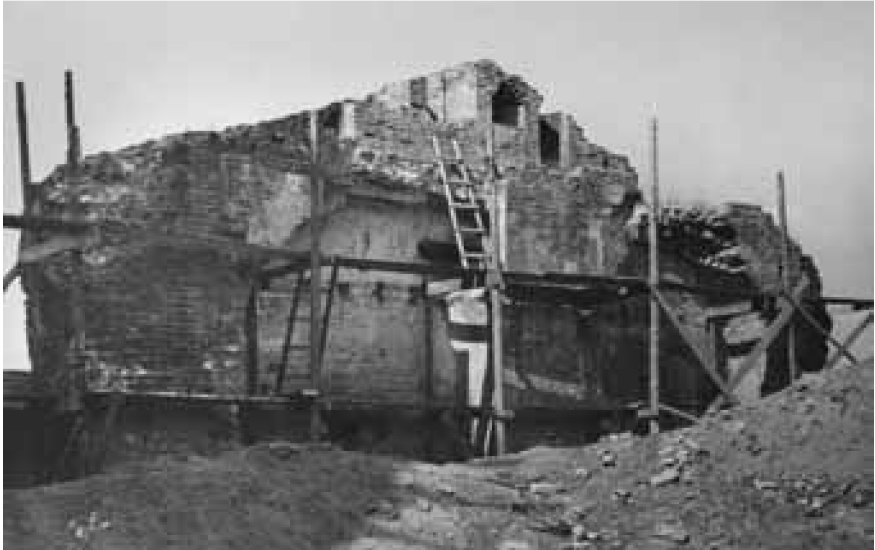
Западное прясло монастырской стены. Сохранившийся фрагмент стены после разборки примыкавшего строения. 1960-е гг.
