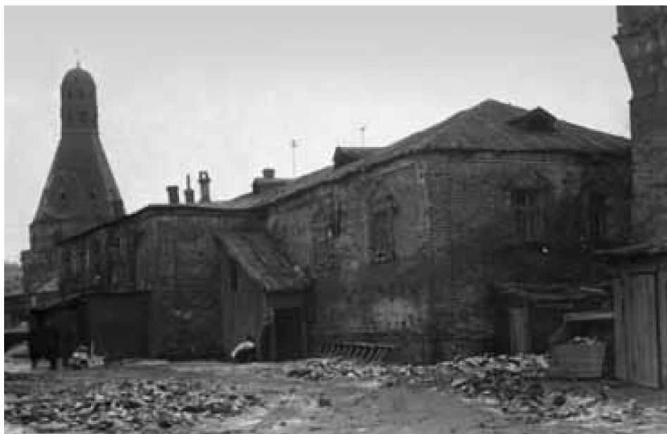
Старая трапезная с северо-западной стороны. 1954 г. Инспекция по охране памятников, № 4511
