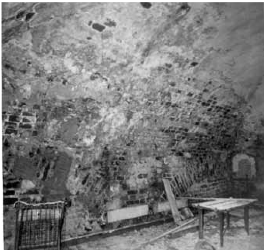
Казначейский корпус. Заложенные арки крепостной стены XV–XVI в. 1990-е гг.
