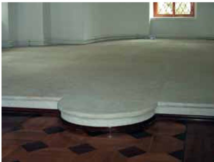
23. Новая трапезная. Северный придел, 2-й эт. Отреставрированный белокаменный пол алтаря и солеи. Июнь 2008 г.
