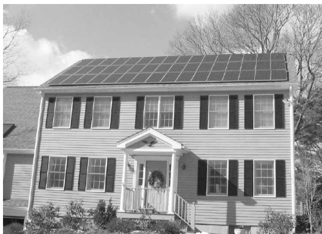
На крышах некоторых современных домов стоят солнечные батареи, генерирующие электричество
